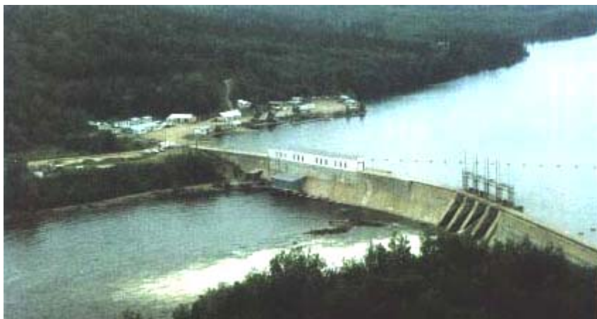
(Photo du Barrage Gouin, en Haute-Mauricie)
