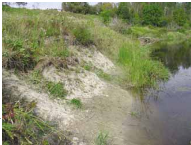
Exemple d'un site d'érosion à la rivière Cameron qui sera stabilisé.
